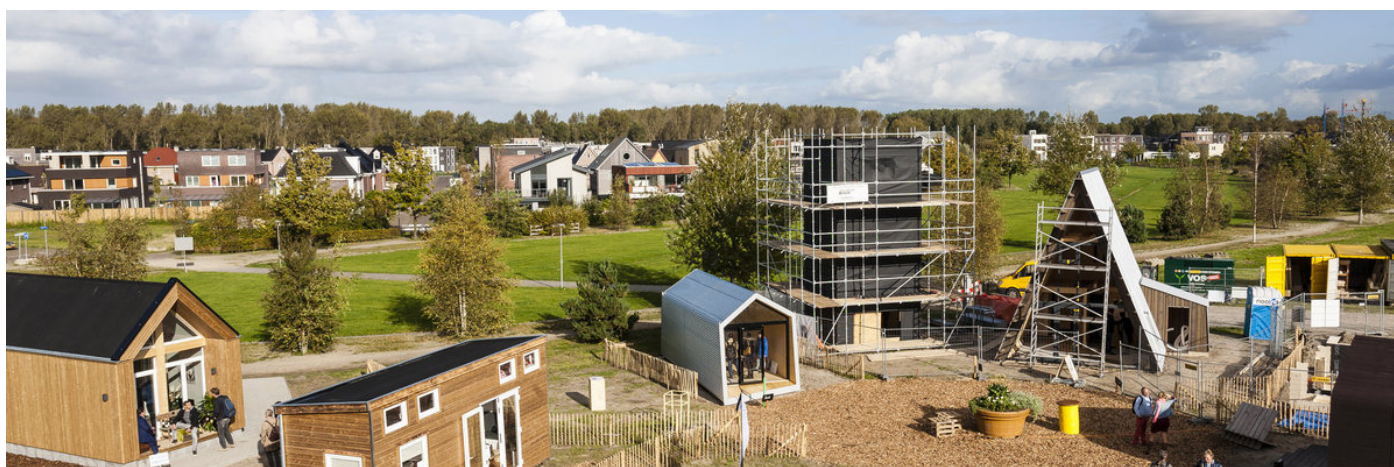
Figuur 14. Tiny house Expo in Almere Poort in aanbouw. Foto overgenomen van (Bouwexpo Almere, 2017)
