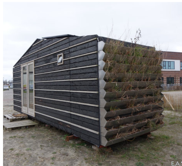
De "groene wand" is los te halen en apart te vervoeren.
