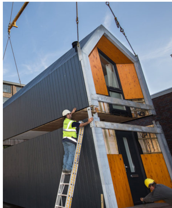
De twee los vervoerbare delen worden op elkaar getakeld en gemonteerd.
