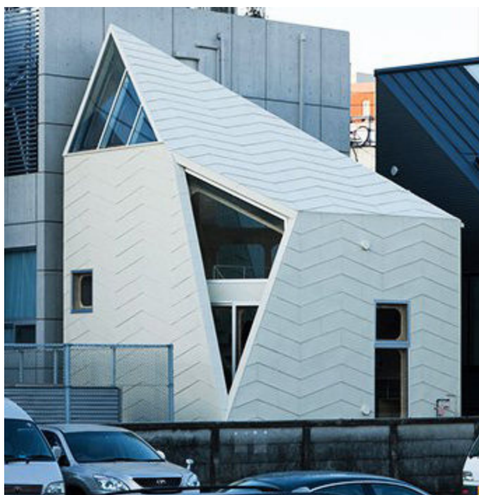
Figuur 5. Tsubomi House ontworpen door FLATHOUSE in Tokyo gebouwd op een klein grondoppervlak (26m 2 ) met 7 split levels om natuurlijk licht en open ruimtes te creëren. Foto overgenomen van architecture art designs (2017).
