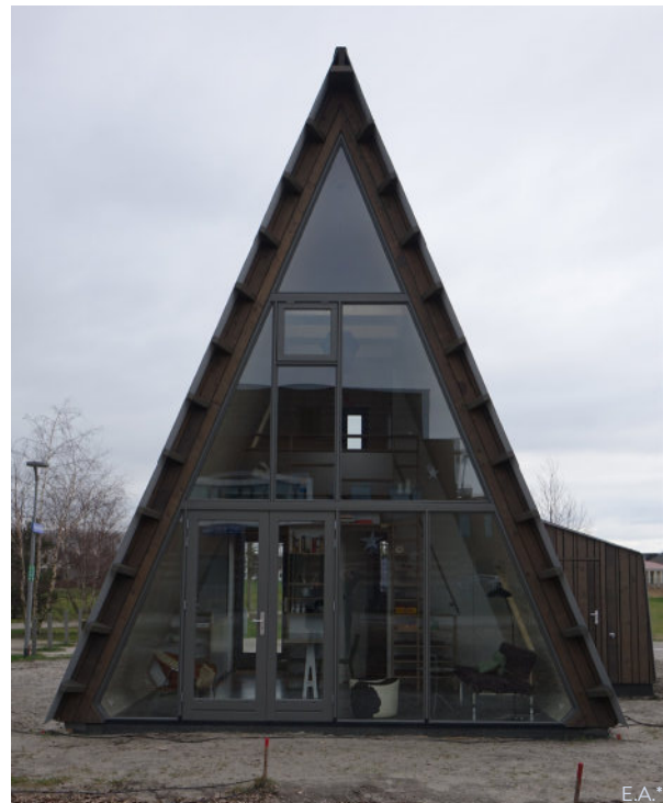
Het dak is opgevouwen met de vrachtwagen verplaatst.
