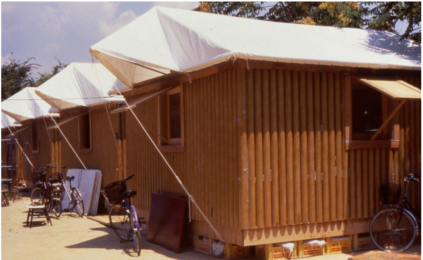
Figuur 7. Shigeru Ban's goedkope tijdelijke woningen voor slachtoffers van de aardbeving in Kobe gemaakt van papieren buizen. Foto overgenomen van (Taylor-Foster & Brittain-Catlin, 2017).
